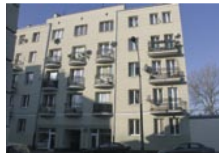
Budynek, ul. Skaryszewska 15
