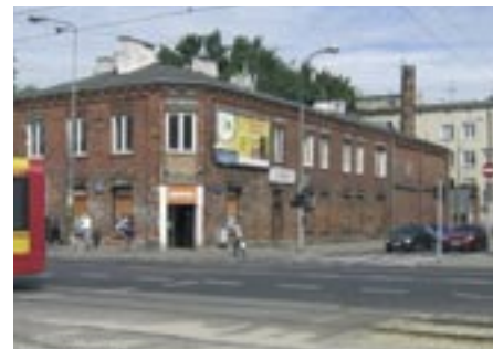
Piekarnia Rajcherta. Zdjęcie zrobiłam w 2007 roku – widać komin wzmocniony metalowymi obręczami
