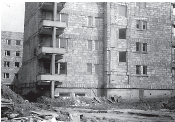
Fot. 1. Widok budynku (433c obecnie Witoszyńskiego 4) w trakcie budowy
