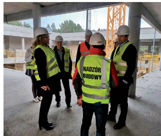
Na budowie liceum
