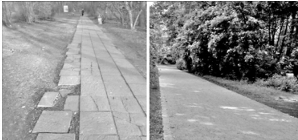
Po lewej aleja przed remontem, po prawej już wyremontowana, równa droga spacerowa
