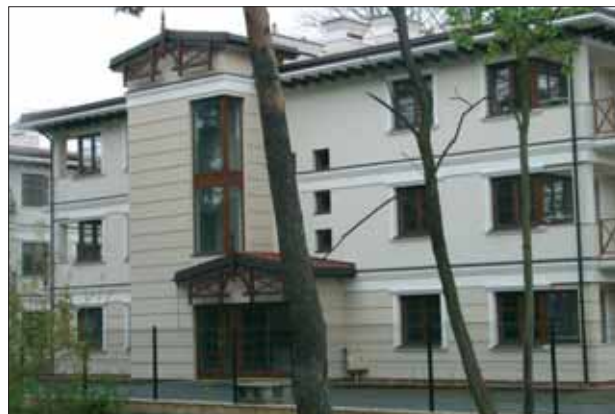
Osiedle w Otwocku przy ul. Kościelnej
