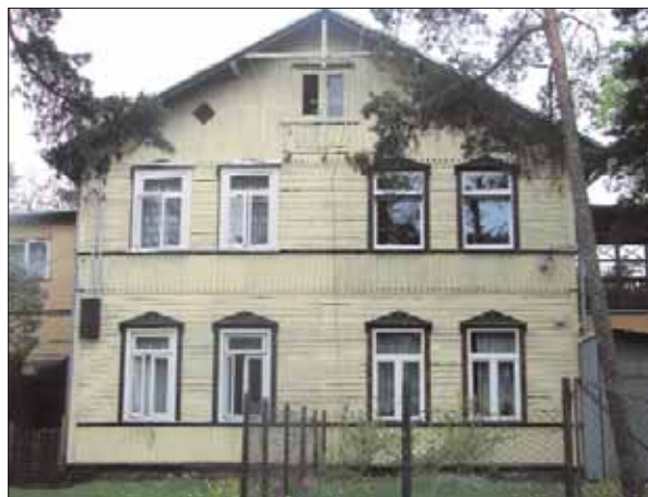
Zewnętrzny szalunek – do wysokości okien deski przybite pionowo, wyżej poziomo. Płaszczyzny poziomego i pionowego deskowania oddziela drewniany gzyms.
