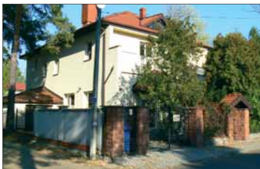
Dom Lotta po remoncie
