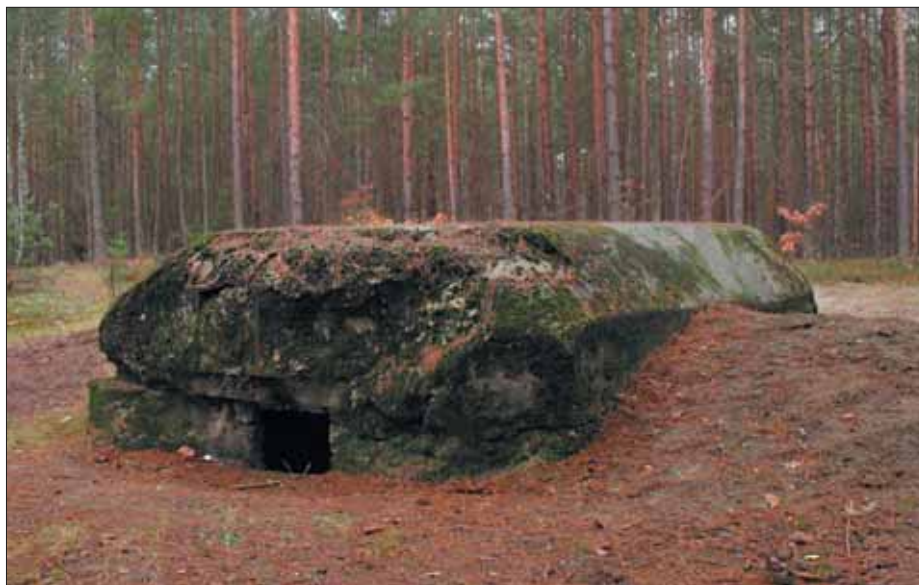
Schron spod Zagórze – widok od strony strzelnicy
