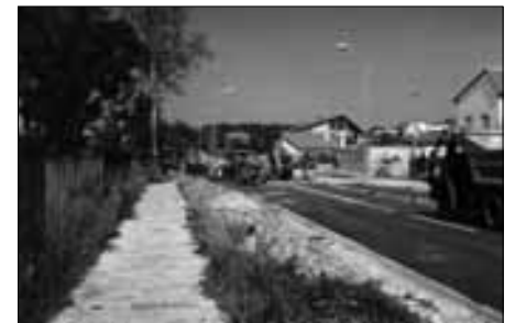
... i w ostatniej fazie budowy.
