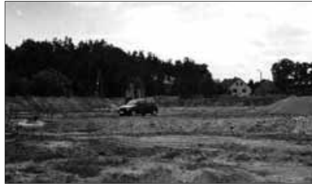
Początkowa faza prac przy budowie boiska
