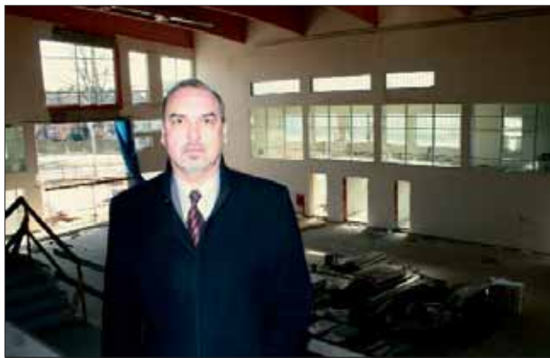
Krzysztof Kacprzak stoi na trybunach budowanej w Starej Miłosnej hali sportowej, której zakończenie planowane jest na rok 2010.
